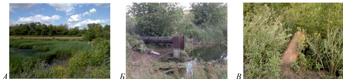
Рис. 8. Фотофиксация объекта № 19 по видам рис. 5: А – вид 1; Б – вид 2; В – вид 3 Примечание: составлено авторами при визуальном обследовании объекта
