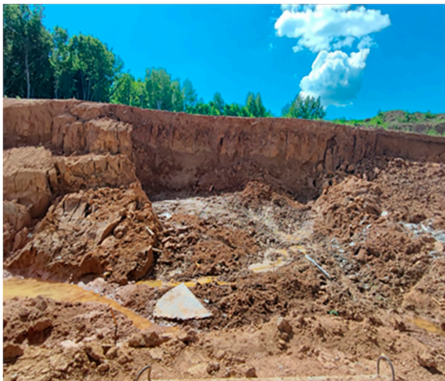
Фото оползня в грунтовой толще делювиальных суглинков погребенного оврага
