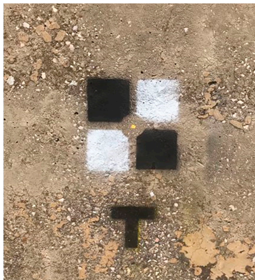
Рис. 5. Наземная контрольная точка, нарисованная на поверхности плотины
