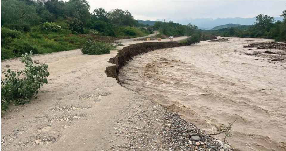
Рис. 3. Размытое полотно обьездной грунтовой автодороги паводковыми водами р. Нальчик
