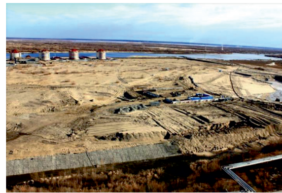
Рис. 1. Начальный вид намывной территории квартала 203 в г. Якутске
