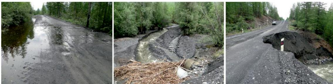
Рис. 3. Подтопление и разрушение полотна трассы «Колыма» во время июльского паводка 2013 г. (Эталонный участок 2)
