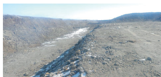
Рис. 3. Открытая водоотводная траншея по периметру карьерного поля
