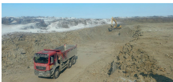
Рис. 2. Формирование водоотводной траншеи в процессе заготовки песка методом БВР
