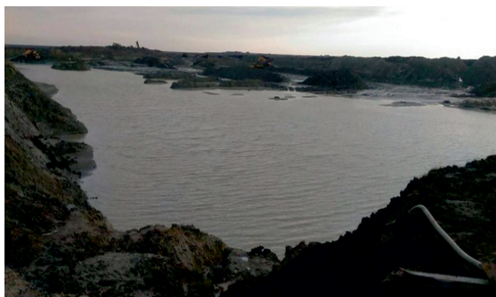
Рис. 5. Карьерное поле с зумпфом, но без водоотводных канав по периметру
