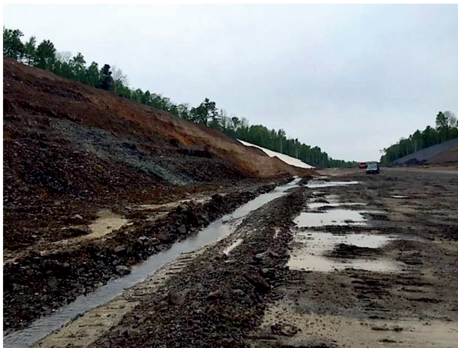
Рис. 2. Водоотводной кювет вдоль борта выемки
