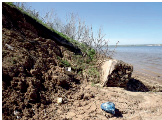
Рис. 3. Воронка интенсивного размыва на границе сооружения
