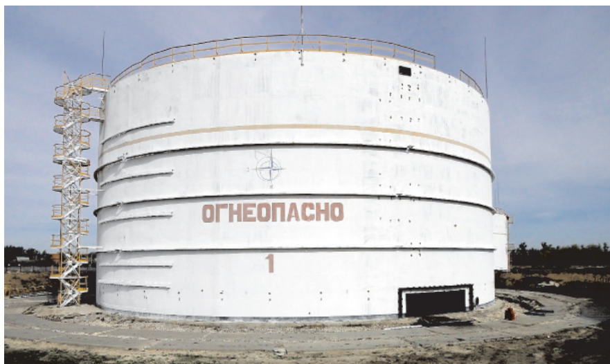
Рис. 1. РВС-20000 на ЛПДС «Воронеж» в процессе ремонта
