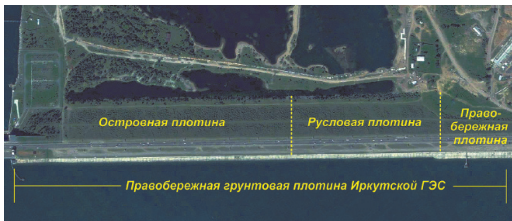
Рис. 1. Правобережная плотина Иркутской ГЭС
