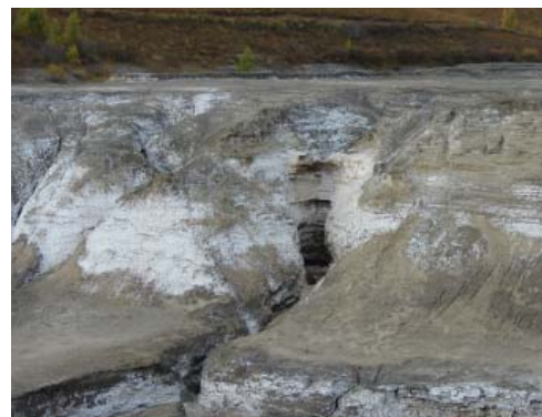
Рис. 2. Хвостохранилище Благодатского ГОКа (слева) и минеральные новообразования (светлое) в стенке промоины в его ложе
