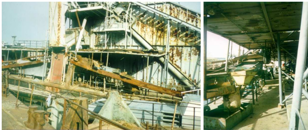
Рис. 1, 2. Компонировка оборудования на земснаряде
